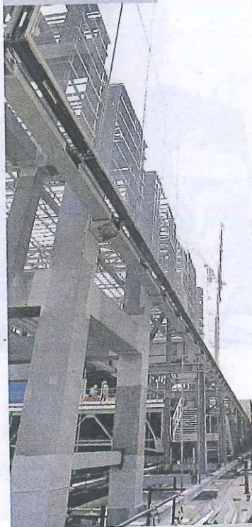
LA NUVOLA Il cantiere della Nuvola dell'architetto Massimiliano Fuksas all'Eur
